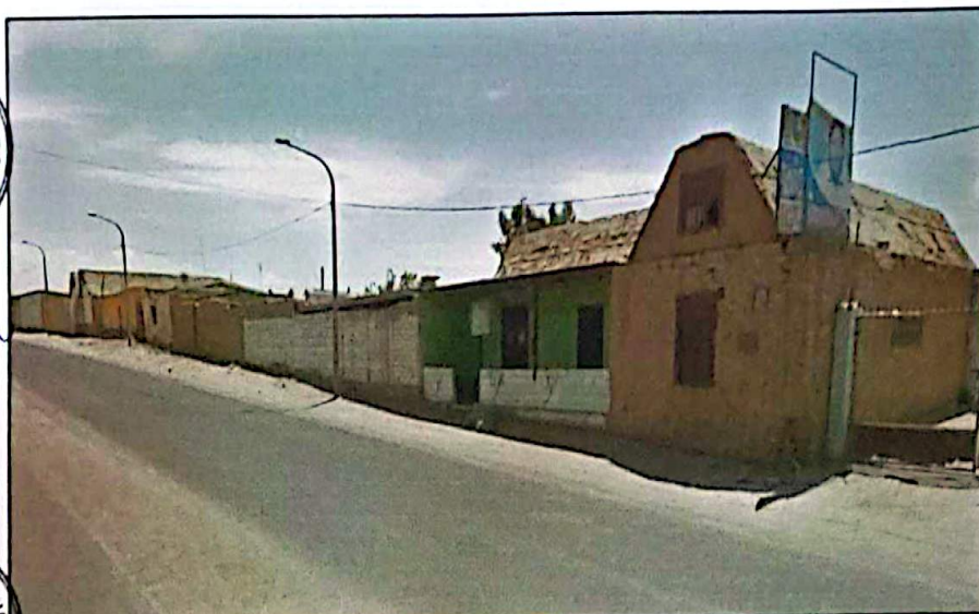
Viviendas de adobe en mal estado de conservación en la Av. Productores identificado como zona crítica 3 por Sismo
