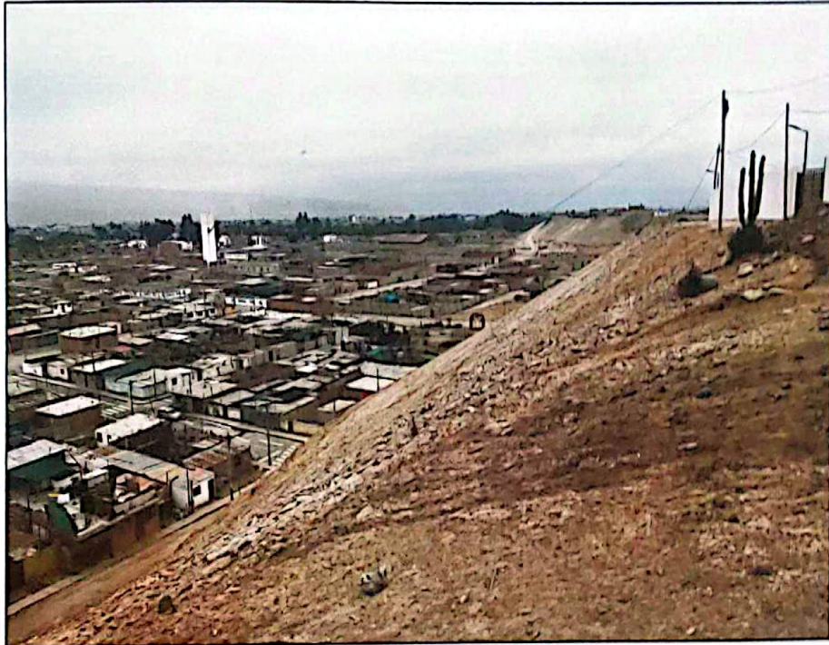
Zona de deslizamiento el Mirador
